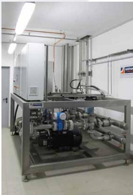
Die neue Waschhalle verfügt über zwei Waschbahnen und ist ganz spezifisch für die Reinigung von Silowagen ausgestattet. Da pro Waschbahn 6 Waschköpfe installiert sind, wird keine Zeit mehr verloren für Umhängen der Waschköpfe. Über temperatur-regulierte Ventile können Hochdruckpumpen auf jeder gewünschten Temperatur gespeist werden. Für den Betrieb eine erhebliche Energiekostensparnis. Nach der Reinigung wird das
